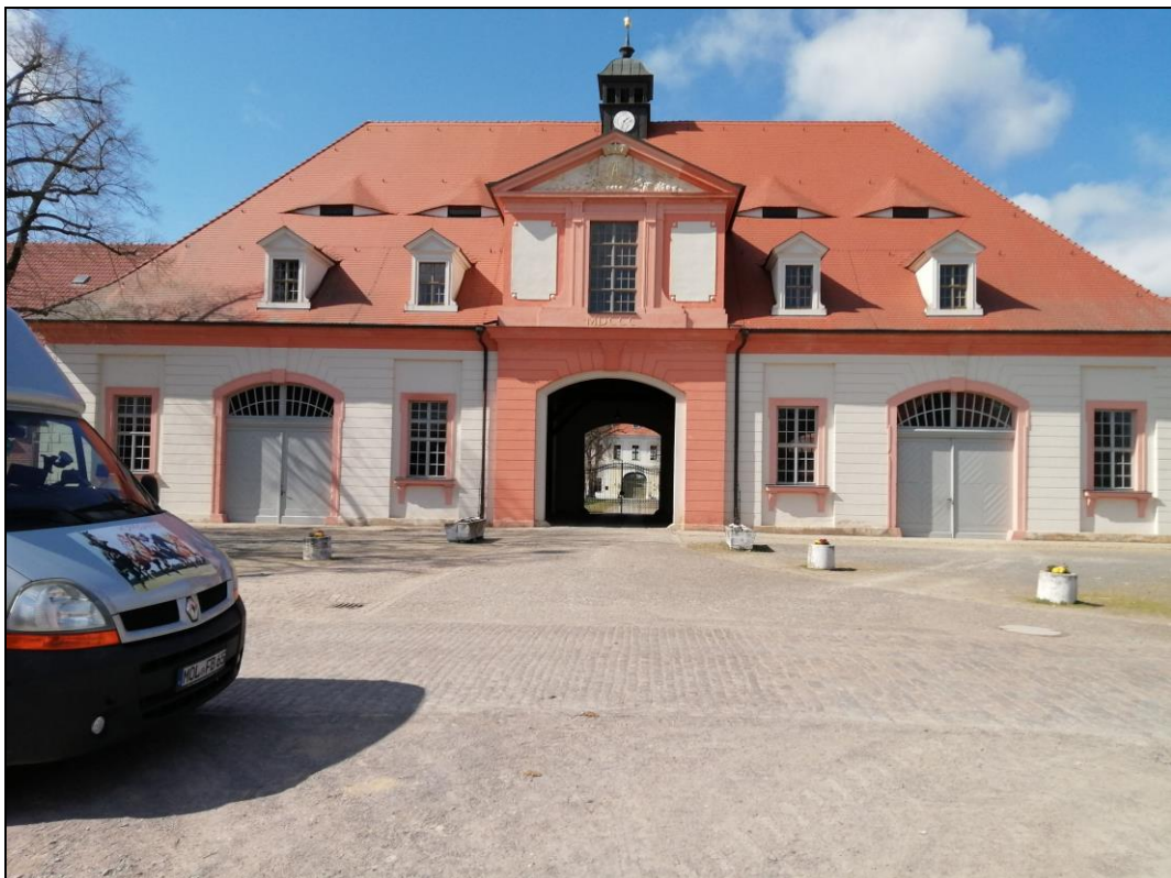
Torhaus in Graditz
