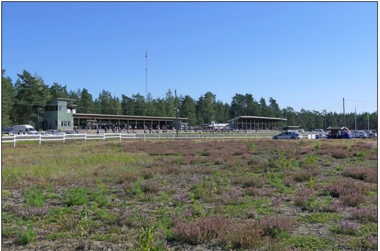
Die Tribünen vom Innenraum aus gesehen
